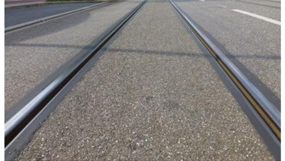
**Corabit ES** ist eine elastomodifizierte Heißvergußmasse gemäß TL/TP Fug StB15 und kommt bei Fugen zwischen Schienen und angrenzenden Belag wie Pflaster, Asphalt oder Beton ohne besondere chemische Beanspruchungen zum Einsatz. Die **Corabit ES** elastische Schienenvergußmasse verhindert das Eindringen von Wasser und Tausalzen in der Schienenfuge.
