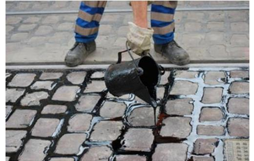
**Corabit P Pflastervergussmasse** ist eine polymermodifizierte, bituminöse **Pflastervergussmasse** nach TL/TP Fug-StB 15 und wird insbesondere für Fugen zwischen Pflasterfugen benötigt.
