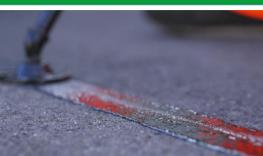
Corabit R ist eine polymermodifizierte, bitumenhaltige Rissmasse gemäß TL/TP Fug-StB 15 und kommt speziell bei der Sanierung von Rissen (auch Oversealbonding) in Asphalt- und Betonbelägen, sowie bei ausgemagerten Straßenbelägen ohne besondere chemische Beanspruchung zum Einsatz.
