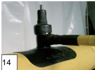
Überstehenden Schrumpfschlauch abschneiden. Fertig installierte Umhüllung muss eng anliegen.
