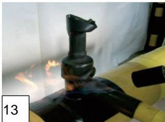
Schrumpfschlauch in der Mitte beginnend über den Ventilsitz und das Ventil schrumpfen.
