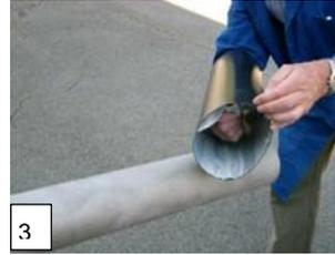
3 An der Ecke die Staubschutzfolie etwas lösen, festhalten und den Schrumpfschlauch auf den Lichtmast schieben.
