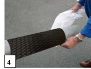
4 Den Schrumpfschlauch positionieren. Die Schutzfolie seitlich herausziehen.
