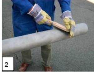
2 Oberfläche durch geeignetes Verfahren (z.B. Strahlen, Handdrahtbürste, Schmirgelleinen) gemäß GW 15 reinigen. Staubreste entfernen.
