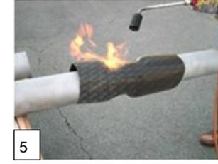
5 Mit einer weich eingestellten Propangasflamme unter gleichmäßiger Bewegung in Umfangsrichtung schrumpfen.
