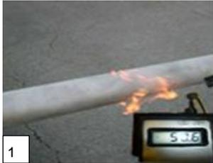
1 Bei vorhandener Restfeuchte die zu umhüllende Fläche mit einer Propangasflamme trocknen und auf 50°C vorwärmen.
