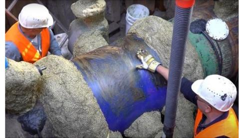
Die **Kebu Plastmasse Spezial** ist eine polystyrolkugelhaltige Masse auf Basis der bewährten **Kebu Plastmasse** zum Auffüllen von Hohlräumen und zum Ebenen von Oberflächen bei erdverlegten Rohrformteilen (z.B. Flansche, Armaturen etc.).
