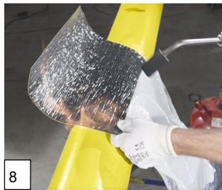
8 Vom abgeschrägten Ende die Trennfolie auf der ganzen Breite und in einer Länge von ca. 300 mm entfernen. Kleber der Manschette erwärmen.
