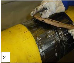
2 Rohroberfläche frei von Fett, Öl, Lösungs- und Kopplungsmittel etc. Rohroberfläche z.B. mit Handdrahtbürste oder Sandstrahlen von Rost, Schmutz und anderen Rückständen reinigen.
