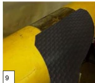
9 Manschette auf das Rohr plazieren (min 50 mm auf Werksumhüllung überlappen, s. Abbildung 1).
