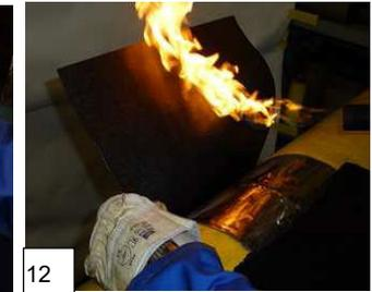
12 Schrumpfmanschette um das Rohr wickeln. Ausrichten und Kleber mit blau-gelber Flamme erwärmen.
